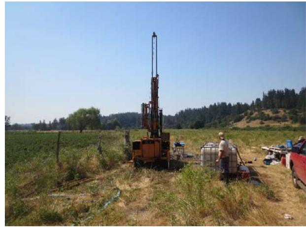
**Fotografía 2-4. Sondeo en la zona de fundación de la presa**
