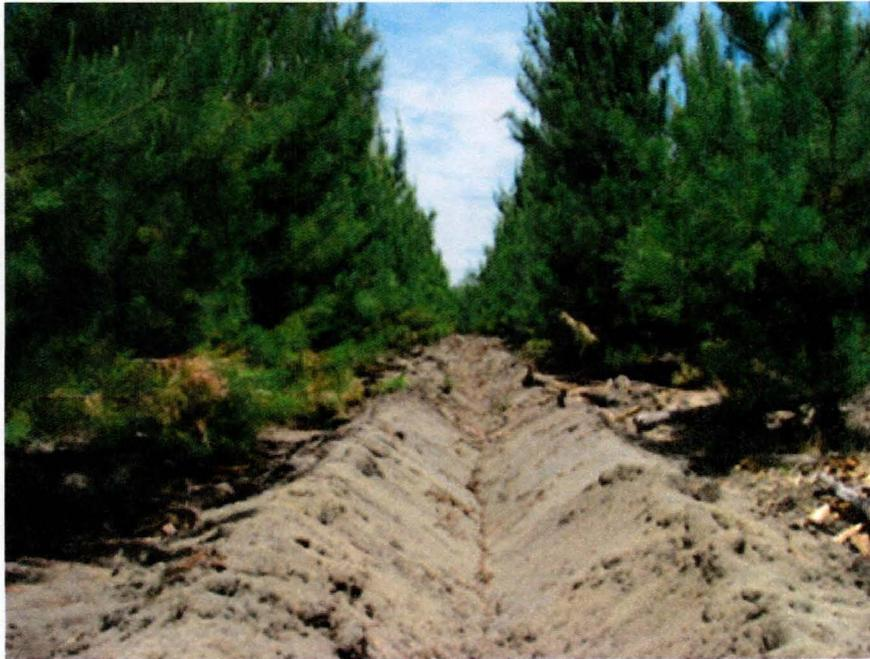
Figura 67. Canales realizados en un suelo arenoso para inducir RAA.
