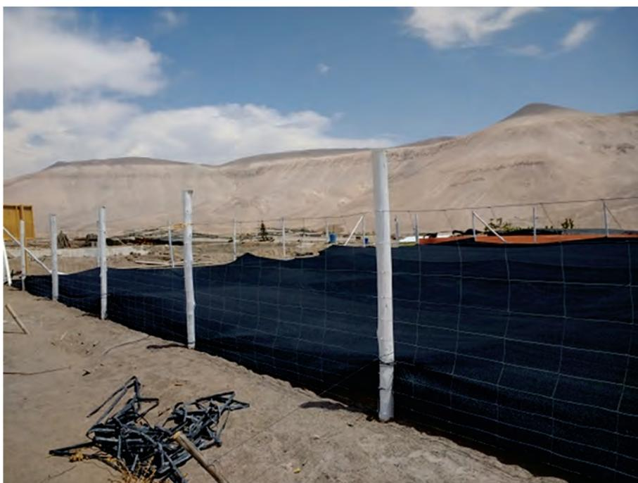
**Figura 28.** Estanque acumulador cercado y tapado para reducir contaminación por algas y animales.
