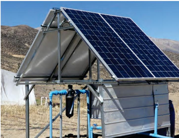
**Figura 24.** Bombeo solar instalado en Módulo Murmuntani.
