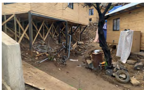
e) Autoconstrucción en el eje de la quebrada P-04
