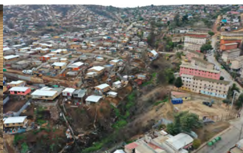
f) Autoconstrucción en laderas y quebrada P-05
