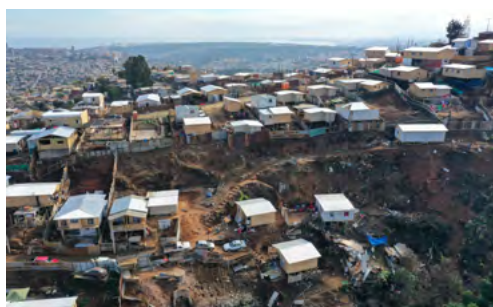
c) Autoconstrucción en laderas P-02
