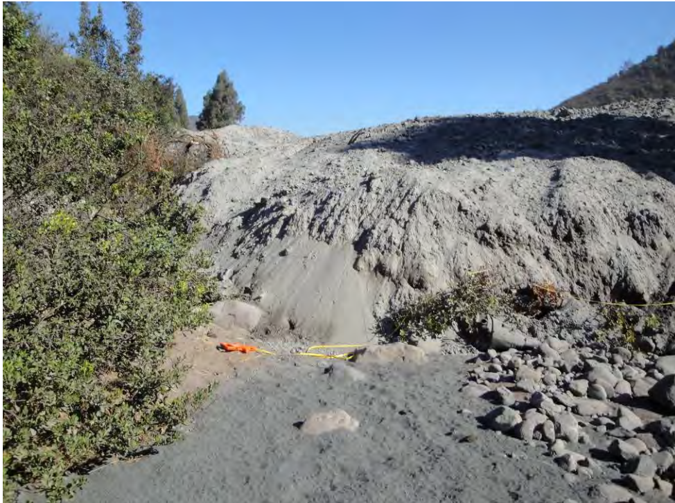
Foto 7: N: 6381723.60, E: 300481.84. UTM (WGS-84). GPS 118. Obstrucción Estero El Sauce Sector Oriente
