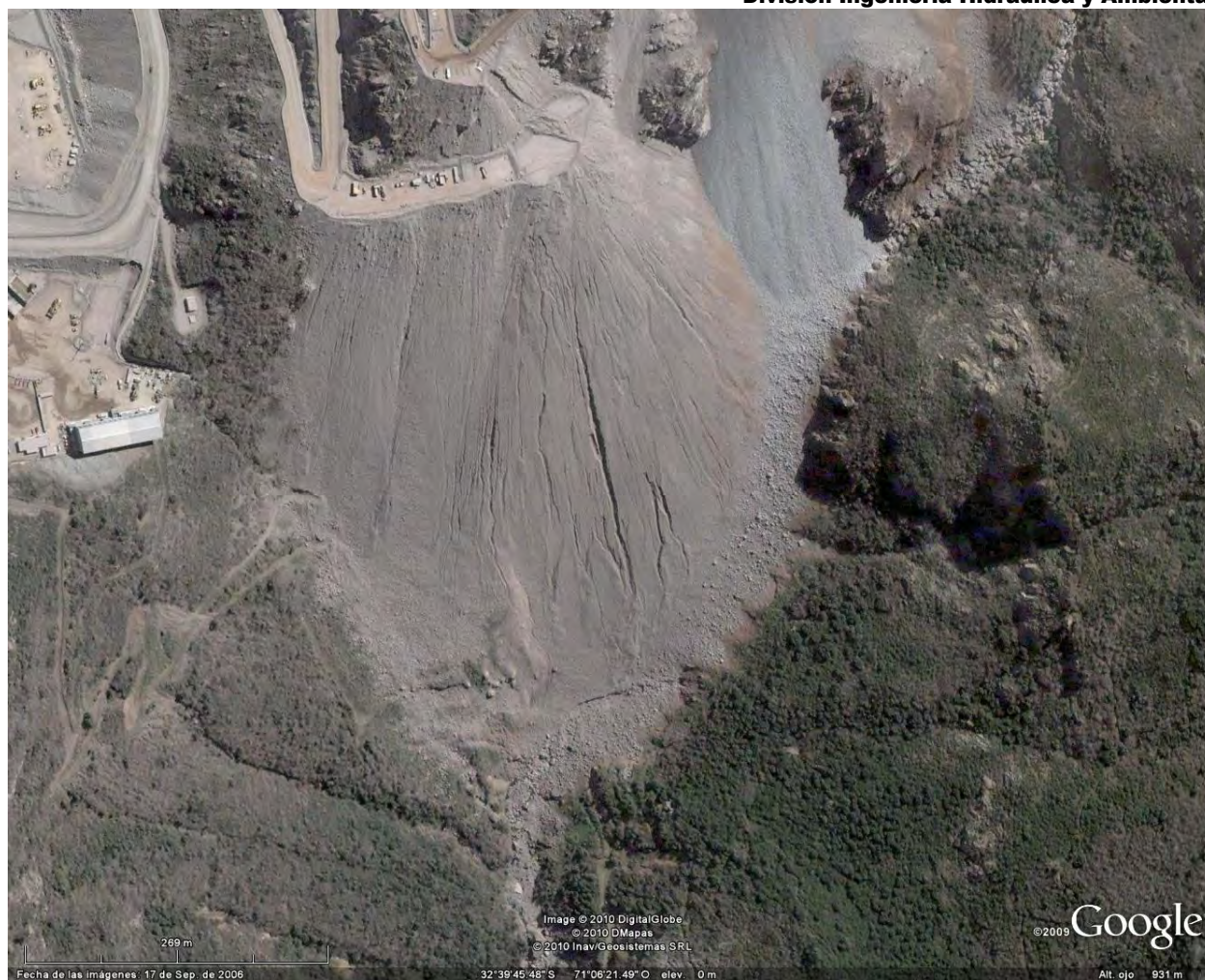
Figura 13. Detalle de la erosión de la ladera que contiene material granular proveniente de la faena minera. Se observa que este material ha bloqueado caminos que existían anteriormente. La presencia de cárcavas en el talud indica que la acción erosiva y la inestabilidad del material aporta sedimentos con un contenido significativo de cobre a la cuenca del Estero El Sauce.
