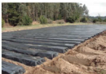
Platabandas terminadas y en condiciones para comenzar la plantación
