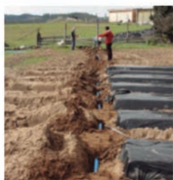
Instalación del sistema de riego localizado
