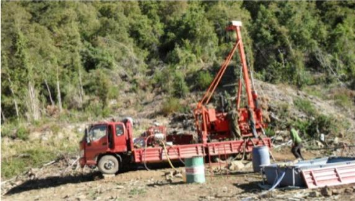
Figura 2-1: Realización de Sondajes
