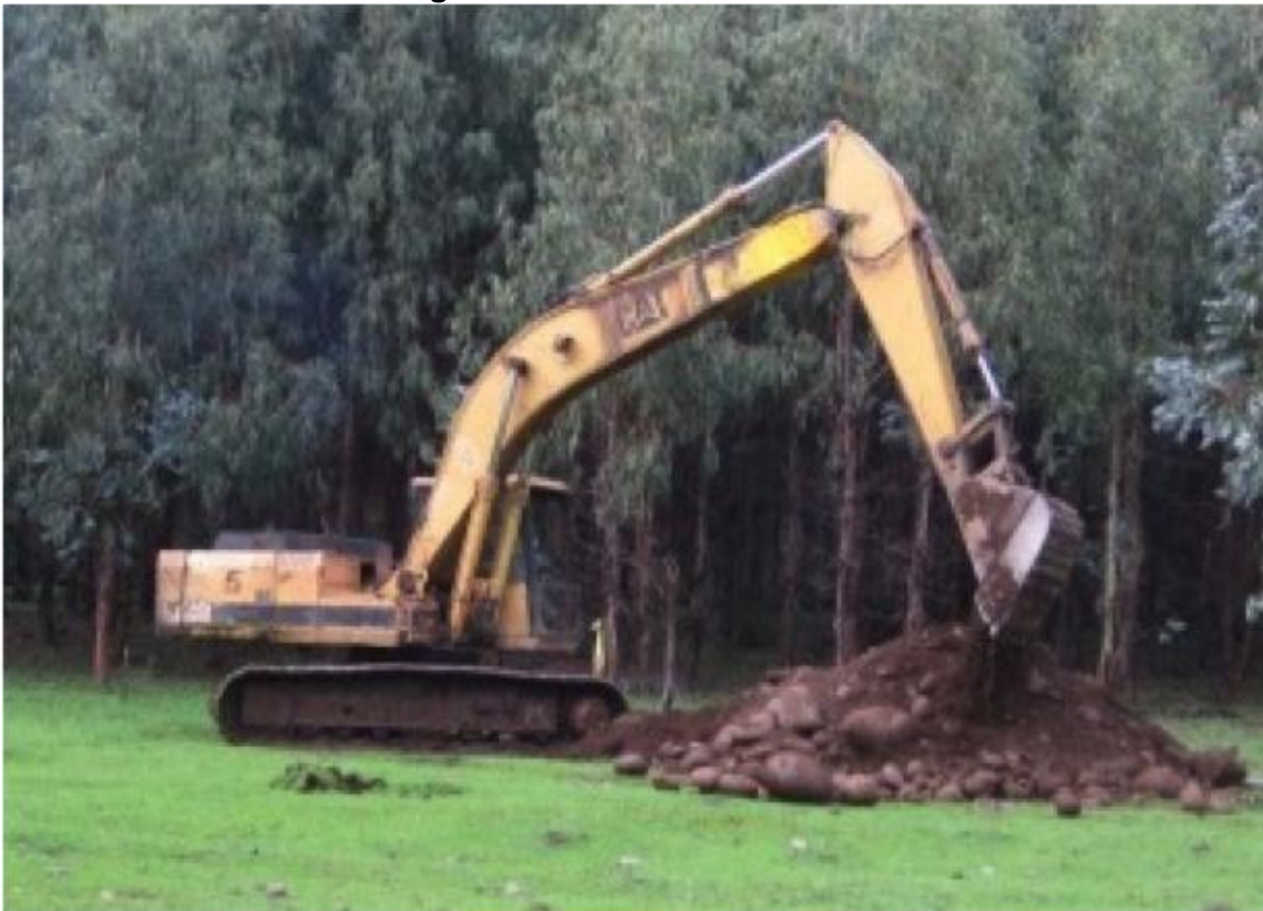
Figura 2-2: Realización de Calicatas
