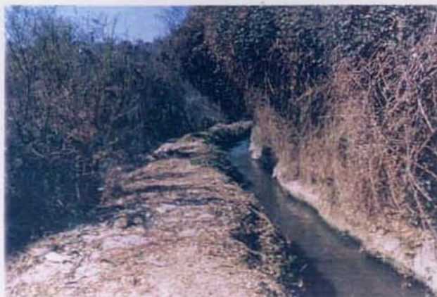
▲South main canal in Mallarauco - Las Carrera area
