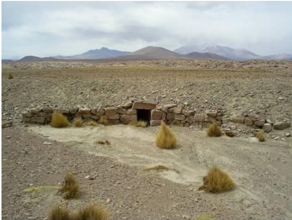
Imagen del Hallazgo N° 16, costado Norte.
