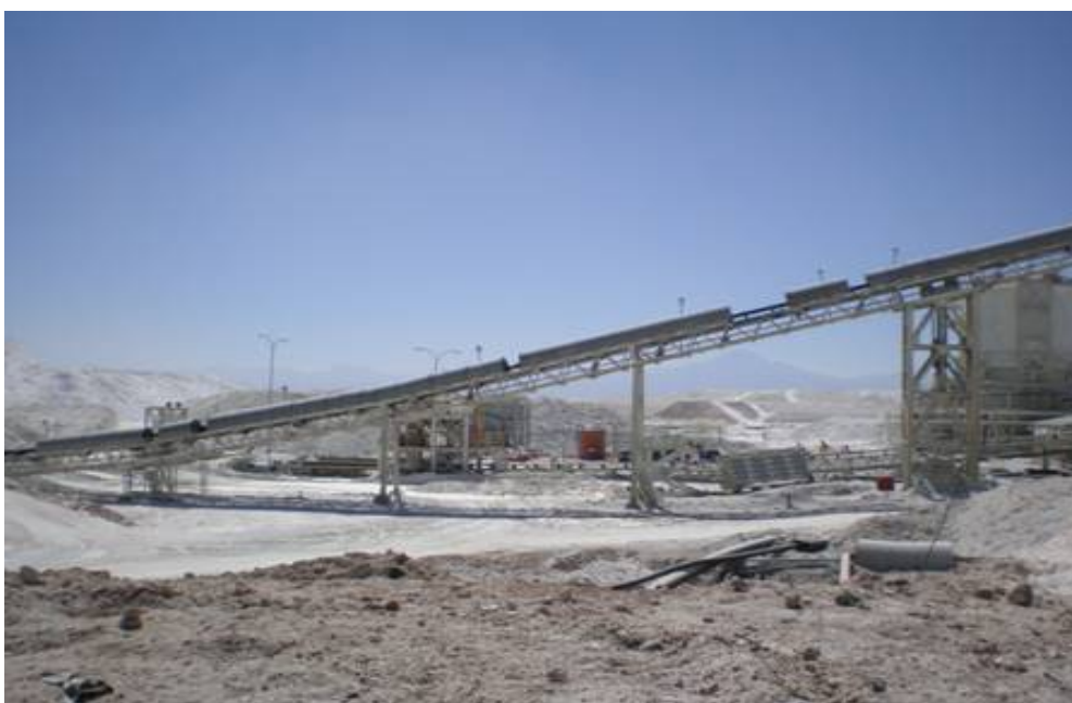
FIGURA 1: VISTA GENERAL ÁREA PLANTA SOP-H
