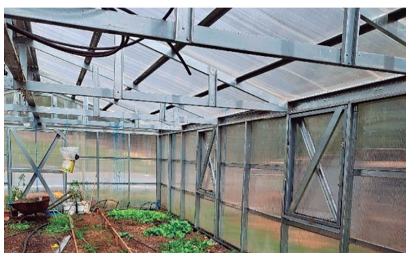
Metalcon y policarbonato.
