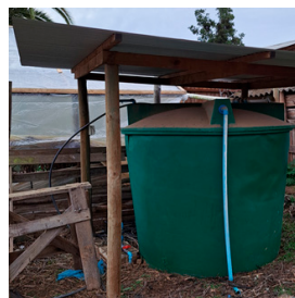
Figura 37. Estanque instalado sin previa compactación o radier.
