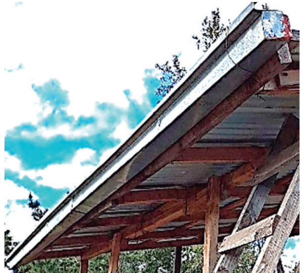
Figura 4. Sistema de canaleta fabricada en hojalata para SCALL.
