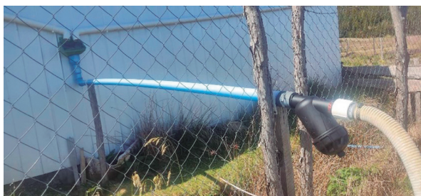
Figura 36. Tubería de conducción instalada a baja altura, sin la sujeción adecuada y sin protección contra el sol.
