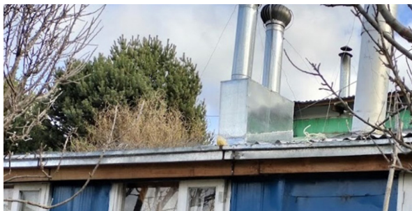
Figura 35. Zona de captación interceptada por los árboles aportando contaminación al sistema.
