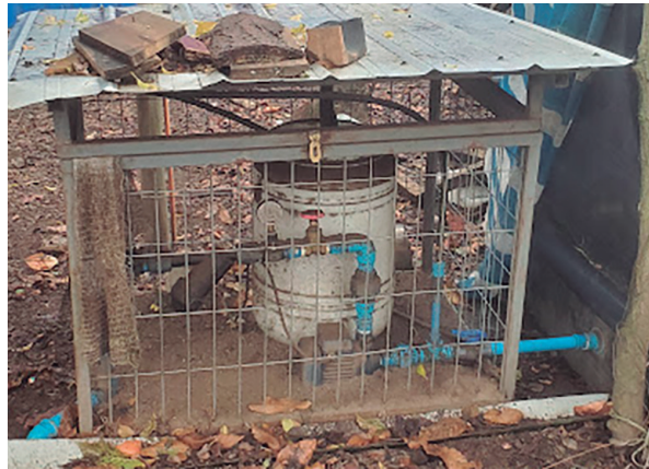
Figura 40. Caseta de control sin el espacio mínimo para operar, mantener y proteger a los equipos.
