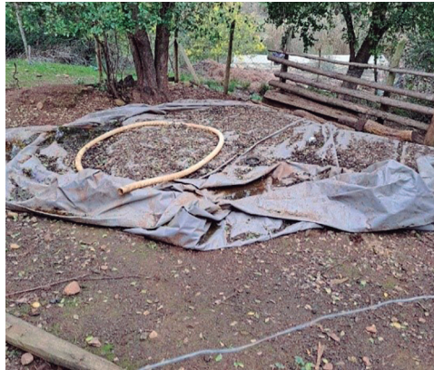
Figura 38. Cisterna flexible desplazada de su ubicación original.
