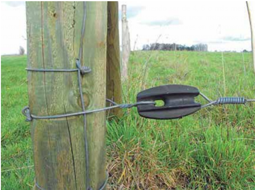
Figura 8.6. Estacas y aisladores terminales.
